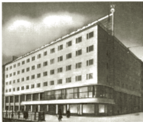
KY:n uuden talonrakennus
